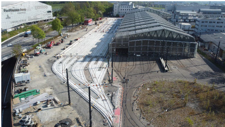
Abb. 19 Bauprojekt Erweiterung Depot Bolligenstrasse
