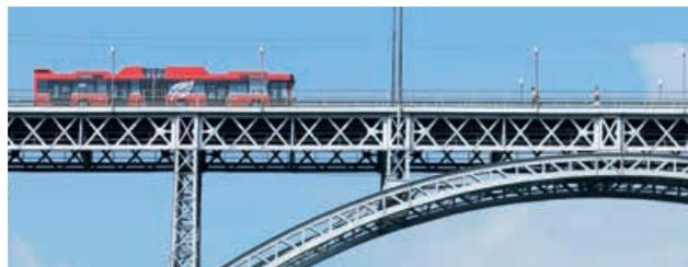
Die Sanierung der Kirchenfeldbrücke ist bereits Vergangenheit. Es wurden unter anderem Risse in der Baukonstruktion saniert, Betonpfeiler erdbebensicher gemacht, Tramschienen und Fahrleitungen ersetzt. Die Brückenkonstruktion wurde nun für weitere 80 Jahre fit gemacht. Was die Gleisanlage betrifft, wird diese natürlich laufend gewartet bzw. ersetzt, damit sie trotz des zunehmenden Verkehrs auch künftig «gut in Schuss» bleibt.
